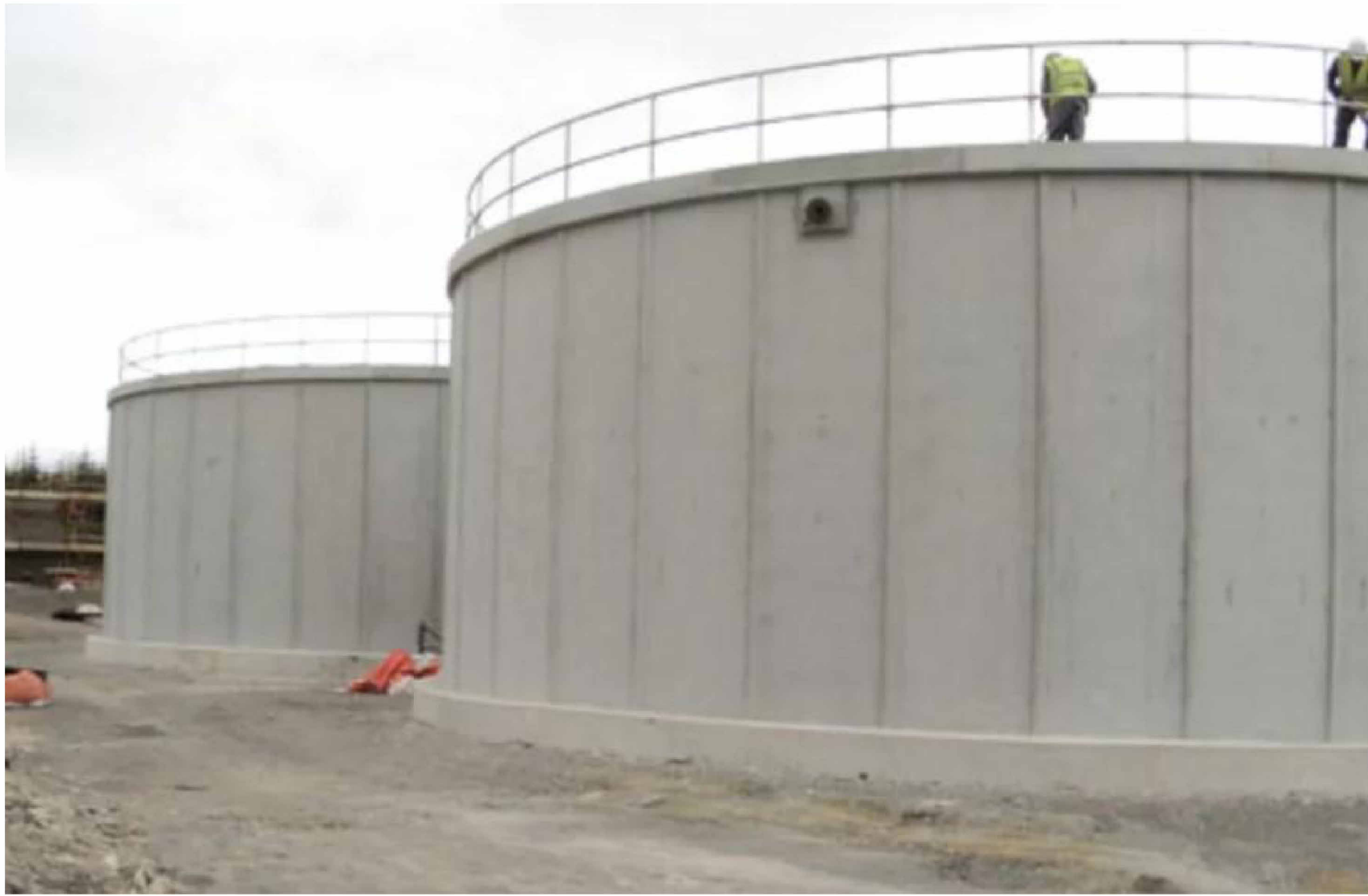
TYPICAL PRECAST STORAGE TANKS (N.T.S)
